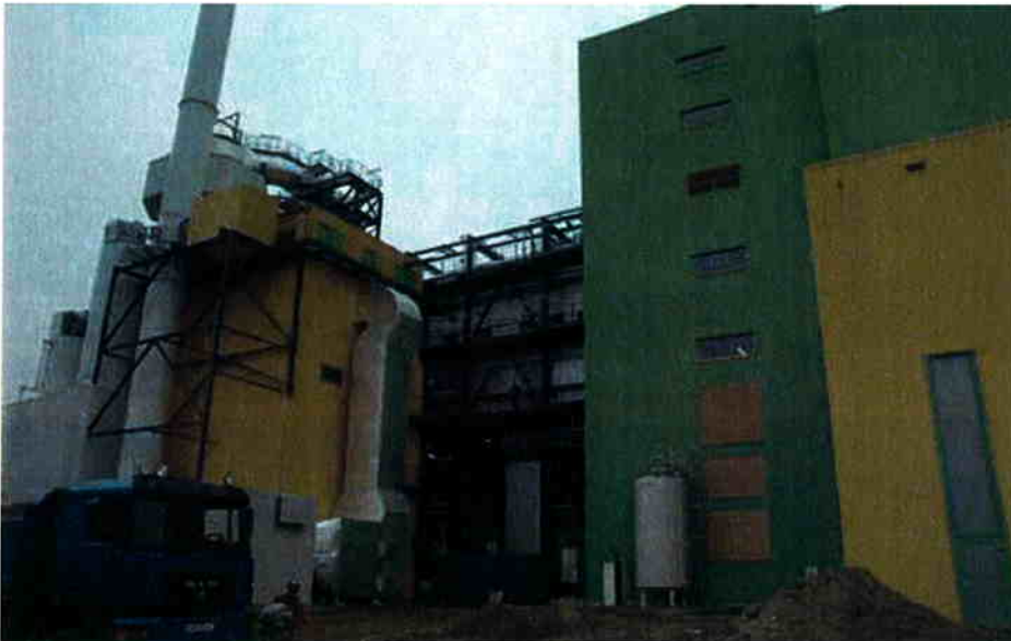
Neues EBS-Kraftwerk in Stavenhagen
